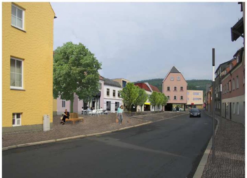
Durch den Abriss der seit Jahren untergenutzten Häuser entsteht ein attraktiver Freiraum für Fußgänger und ein neuer, lichter Charakter der hinteren Rathausstraße. Bestehende und neue Geschäfte erhalten komfortable Vorzonen und werden wesentlich aufgewertet.
