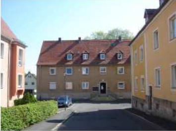
Bauvereinstraße, heutiger Zustand
