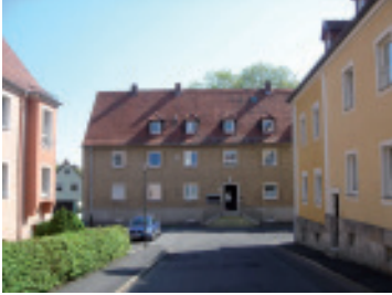
Bauvereinstraße, heutiger Zustand
