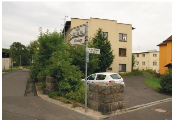
16 Die ehemalige Porzellanfabrik im Schlottenhof von der Egerstr. aus gesehen
