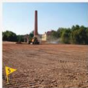
Vorbereitende Maßnahmen Landschaftsbau
