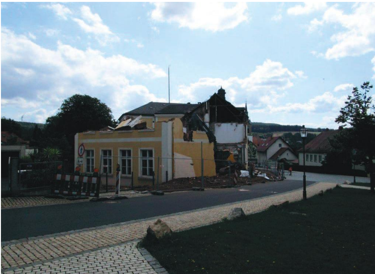
14 Die Fassade des ursprünglichen Zentralschulhauses von 1881
